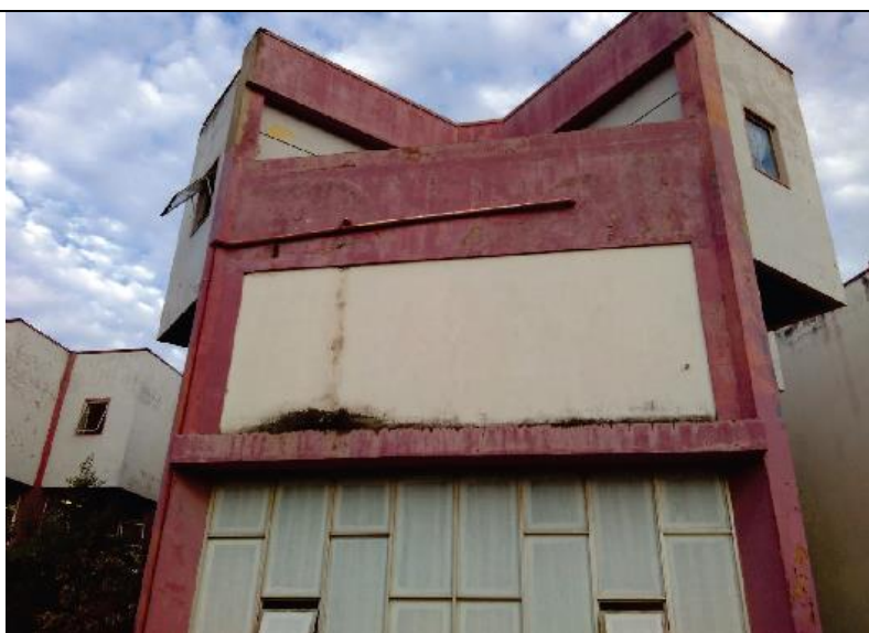
Registro das atuais condições de precariedade dos revestimentos de fachadas da edificação.
