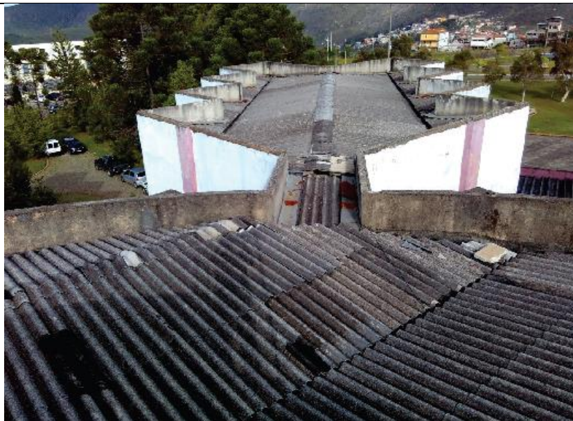
Registro das atuais condições da cobertura que apresenta com um sistema de recobrimento tecnicamente ineficiente ao desenho arquitetônico irregular da edificação.
