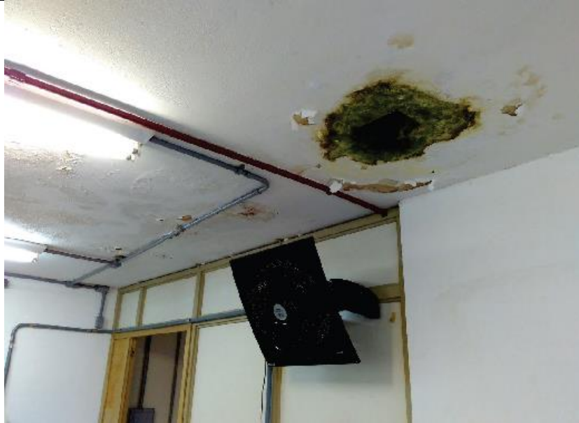
Registro das infiltrações crônicas apresentadas pela edificação que não podem ser sanadas
